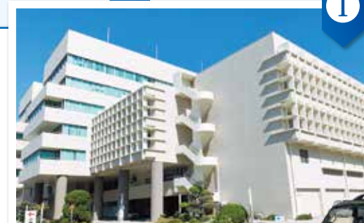
沖縄県産業支援センター 改修工事
