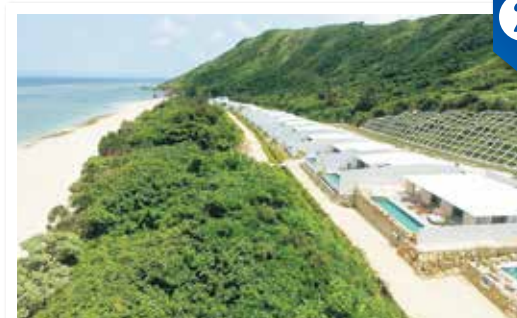
ザ・リスケープ宮古島 改修工事
